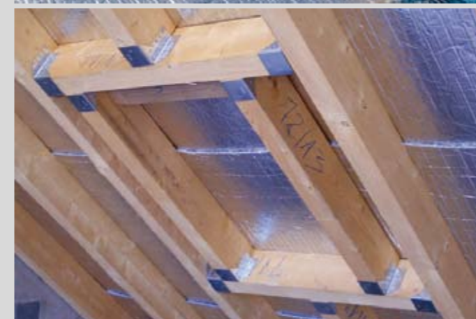
Atspindinčioji izoliacija montuojama paprastai ir greitai, svarbiausia palikti 2–2,5 cm oro tarpą iš abiejų izoliacijos pusių
