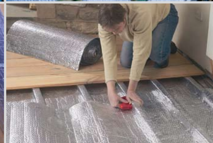
Atspindinčioji izoliacija montuojama paprastai ir greitai, svarbiausia palikti 2–2,5 cm oro tarpą iš abiejų izoliacijos pusių
